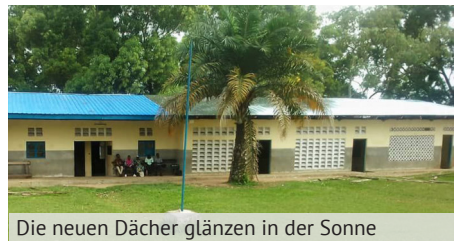
Die neuen Dächer glänzen in der Sonne
