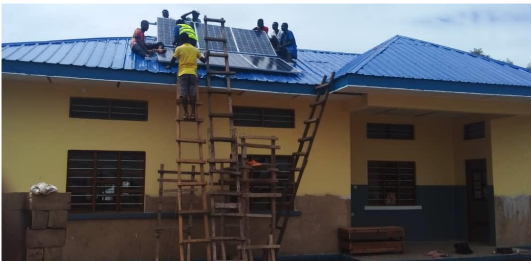
Abbildung 5: Rechenzentrum in Mosango
